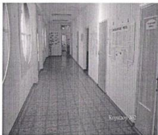
Фото № 12 Пути эвакуации
