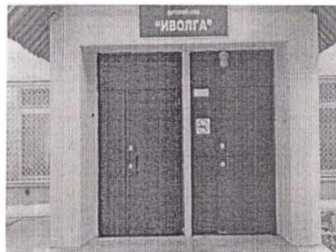
Фото № 4 Дверь входная
