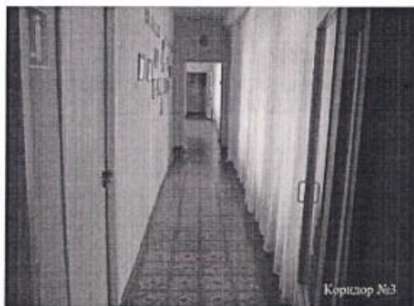
Фото № 10 Пути эвакуации
