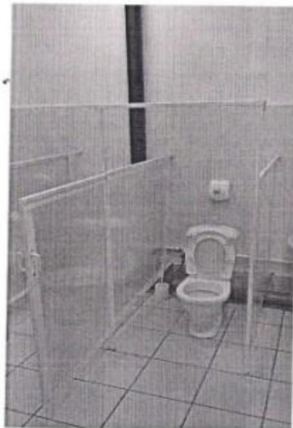
Фото № 15 Туалетная комната
