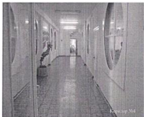
Фото № 13 Пути эвакуации
